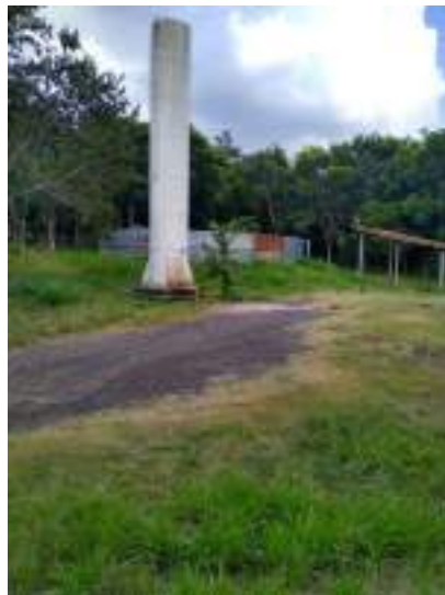
FOTO 02 – RESERVATÓRIOS DE ÁGUA
